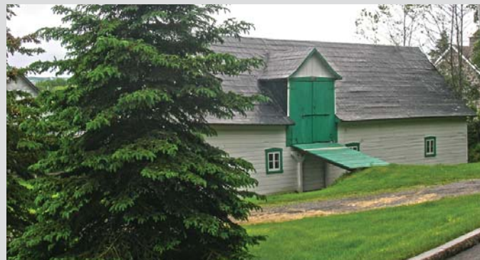
Grange-étable à toiture à deux versants de pente forte (+45°)
