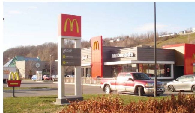
L’affichage commercial du restaurant Mc Donald’s du boulevard Sainte-Anne a été modifié en 2011. Il est possible de travailler de paire avec les grandes chaînes commerciales.
