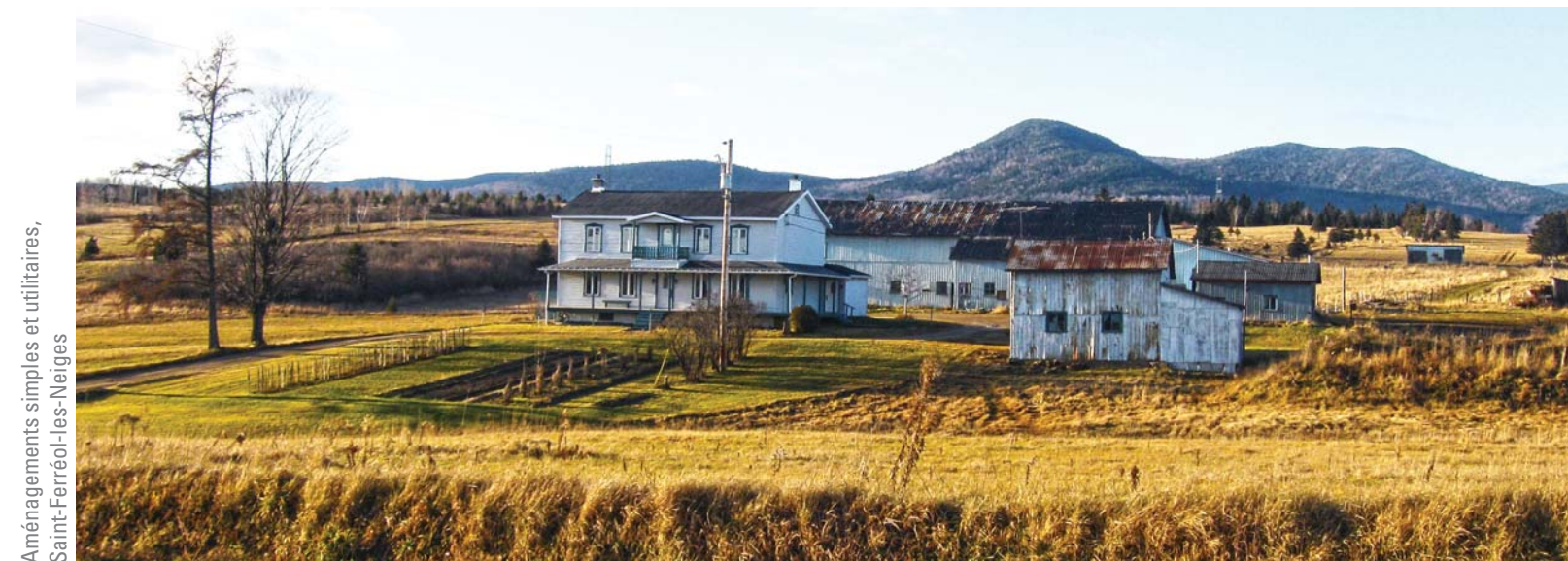
Bâti secondaire neuf, bien intégré au bâti principal, Boischatel
