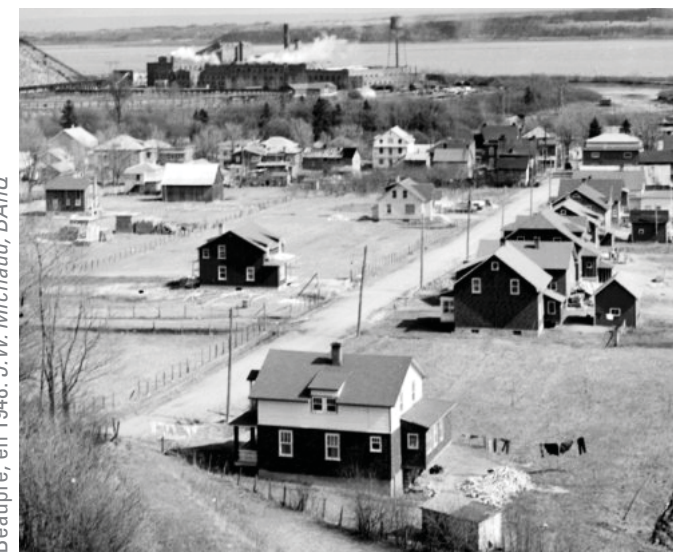
Rue avec habitations ouvrières près de la papetière, à Beaupré, en 1948. J.W. Michaud, BAnQ
